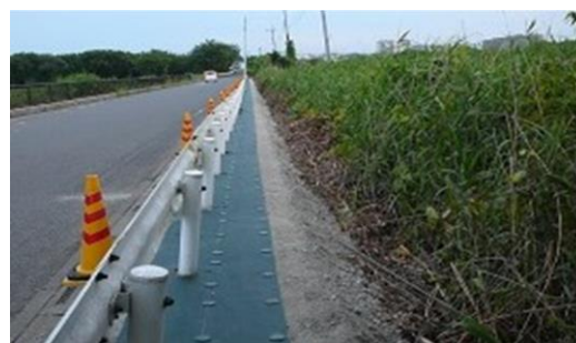
（防草シート施工後）
