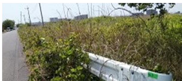
（防草シート施工前）
